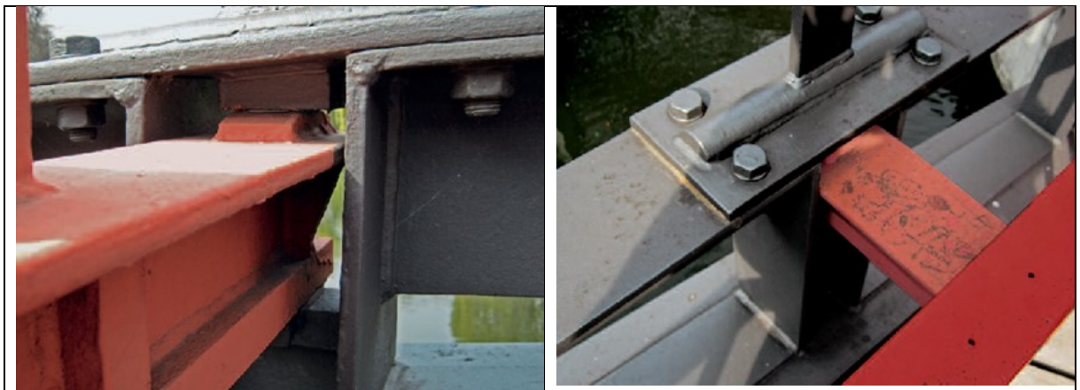
Abbildung 12: Detailfotos einer Inspektion der Beschichtung nach 27 Jahren.
