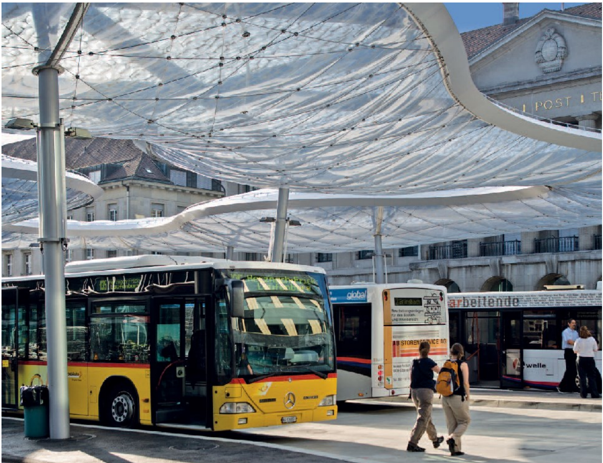
Abbildung 3: Busbahnhof Aarau im Duplex-System (Entwurf: Vehovar Jauslin in Zusammenarbeit mit formTL; Foto: Niklaus Spoerri)
