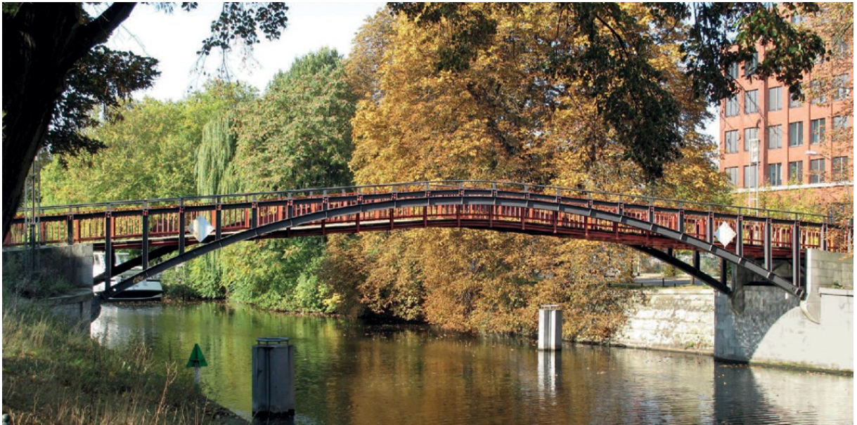
Abbildung 11: Fußgängerbrücke Hiroshimasteg, Duplex-System
