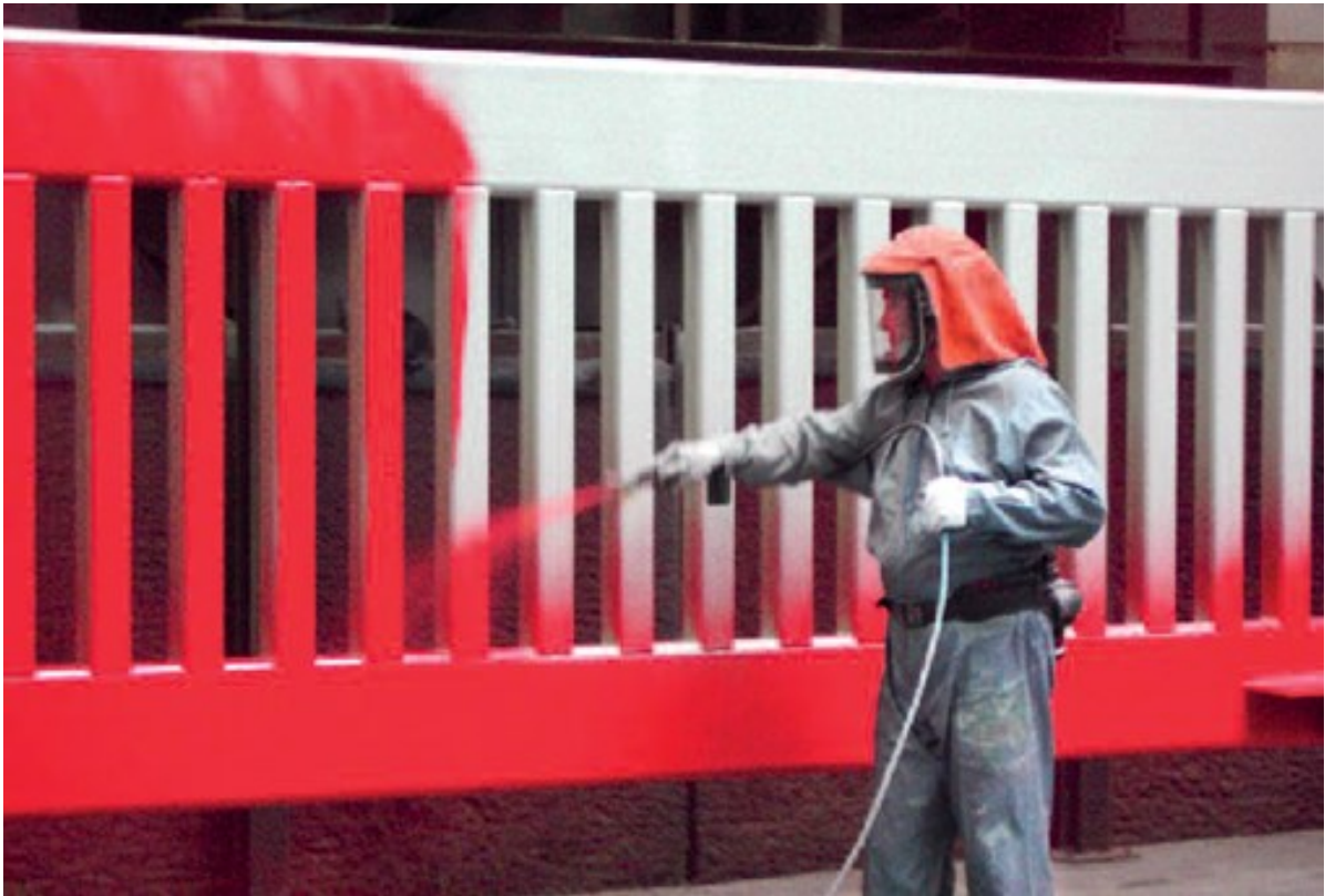
Abbildung 6: Nassbeschichtung einer feuerverzinkten Fußgängerbrücke
