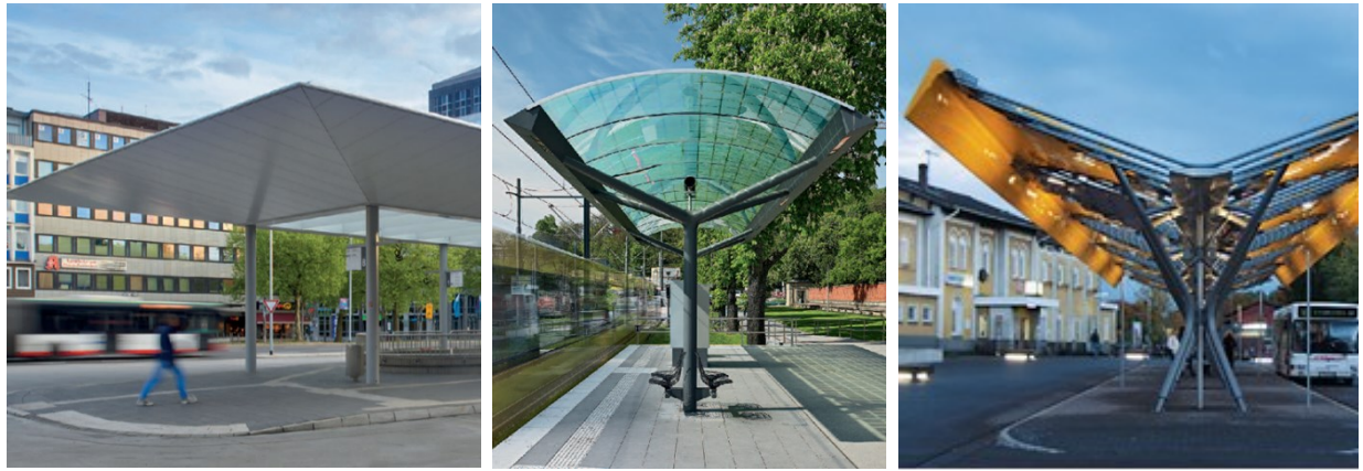
Abbildung 19: Duplex- beschichtete ÖPNV-Bauten: ZOB Bochum (Böll Architekten); Haltstelle Wilhelma Stuttgart (Kaag Schwarz Architekten); ZOB Emsdetten (OX2 Architekten)
