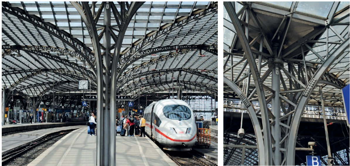
Abbildung 10: Vorhallendächer des Kölner Hauptbahnhofs im Duplex-System.
